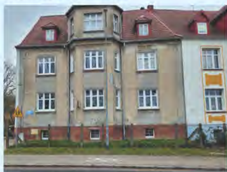
W tym budynku znajdowała się Przychodnia Kolejowa, miejsce pracy pani Bronisławy.
